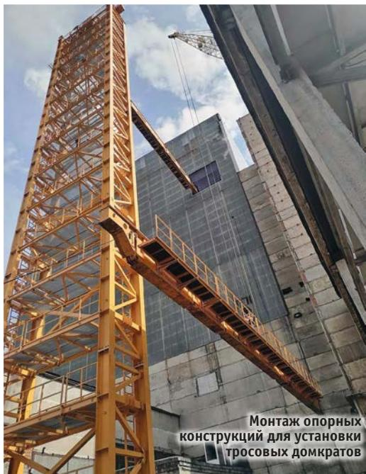
проектов мы поднимали барабан снаружи цеха, а затем заводили его внутрь на высоте около 40 м. Для этой работы была спроектирована и изготовлена модульная башня высотой 41 м (сейчас мы задействуем это оборудование в других проектах с тросовыми домкратами в разных комбинациях).
