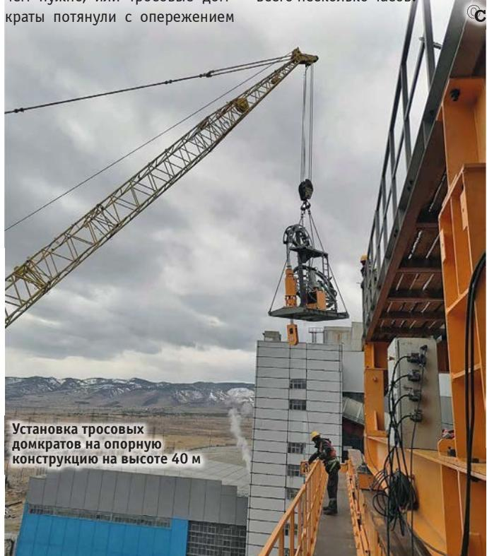
Установка тросовых домкратов на опорную конструкцию на высоте 40 м
