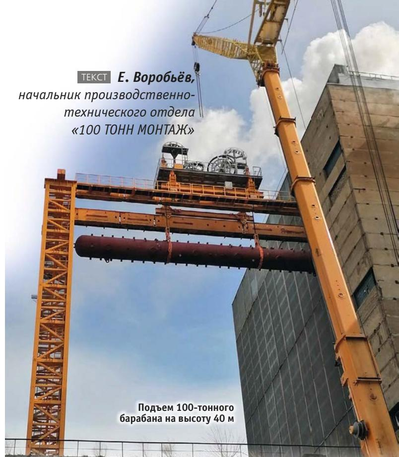
Подъем 100-тонного барабана на высоту 40 м
