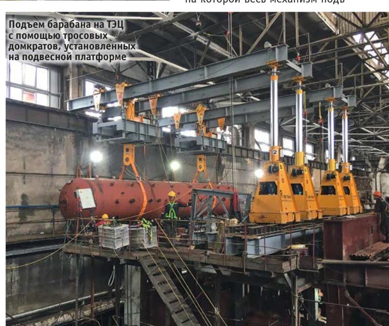
Тросовые домкраты применяются при строительстве мостов. В судостроении их используют для установки двигателей и реакторов на ледоколах или вытягивания нефтяных платформ из дока. Это оборудование использовалось в проектах по подъему на поверхность затонувших судов и подводной лодки.
