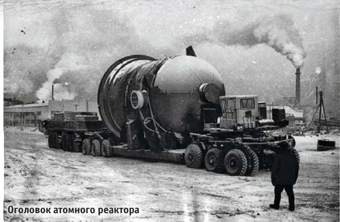
Оголовок атомного реактора
