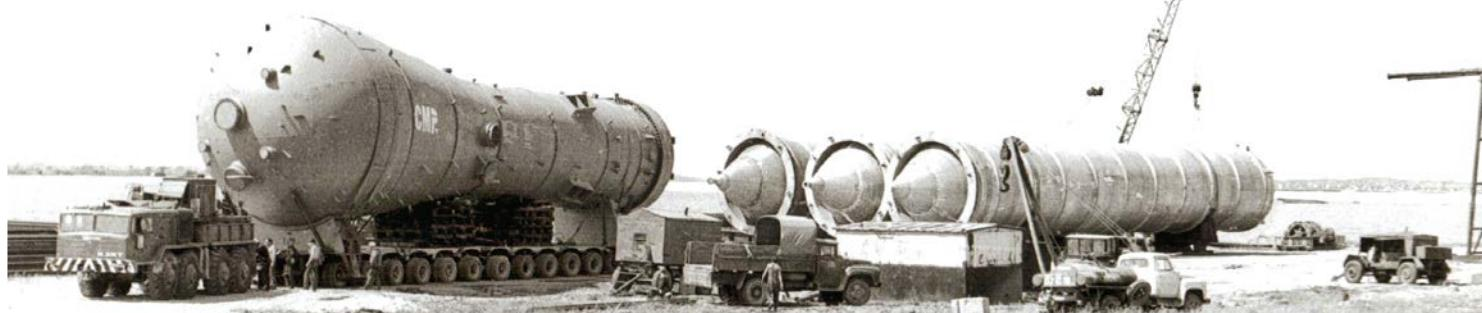
Перевозка из Франции в г. Казань, на з. «Оргсинтез». Реактор довезли до площадки разгрузки такелажным способом, стали монтировать, уронили, повезли обратно на проверку. Середина 80-х годов
